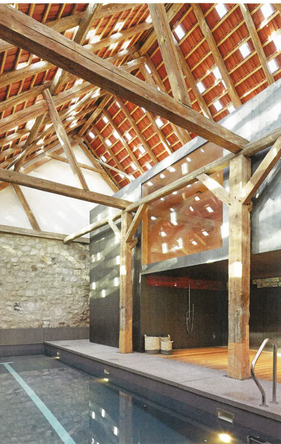
Wellness pur: In der Scheune sind ein Pool mit Ruhezone und die als Zwischengeschoss eingeschobene schwarze Box angeordnet. Ein Teil der Dachdeckung besteht aus transparentem Plexiglas.
